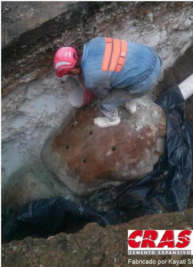
Vemos en las imágenes que acompañan este reportaje diversas fases en el uso del CRAS para la demolición de algunos de estos bolos. En primer lugar, se observa el trabajo de perforación. Se han utilizado diámetros de 35 y 40 mm, con una disposición al tresbolillo, adaptada a la
