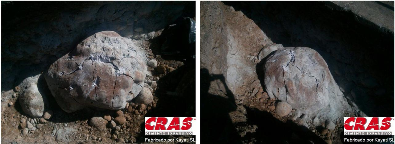
Todo el proceso se desarrolla en total seguridad, sin que se produzcan ni explosiones, ni proyección de material, ni vibraciones.
