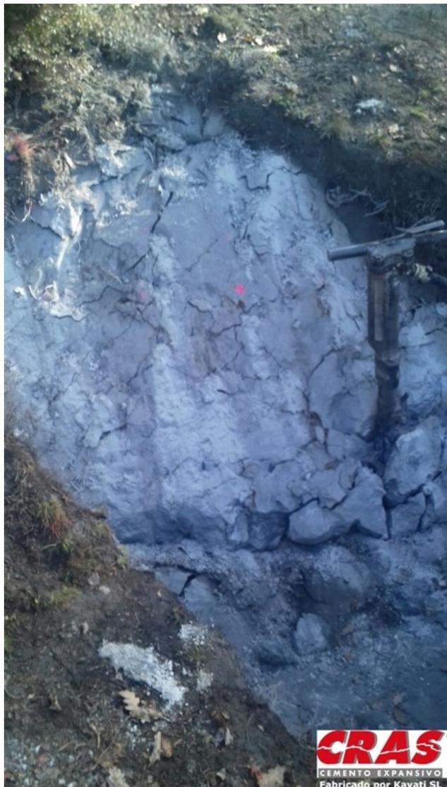
La forma de demoler del CRAS, sin explosiones ni vibraciones, permite realizar demoliciones en entornos naturales, incluso protegidos, con un mínimo impacto ambiental. El cemento demolidor solo genera residuos inertes, que no causan daño al entorno. Estamos pues, ante un producto que ayuda a la demolición en el entornos remotos y variados..
