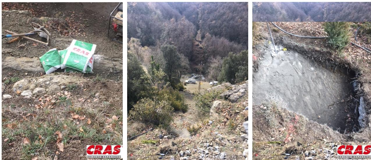
En el caso de la construcción de tendidos eléctricos, el CRAS permite realizar vaciados prácticamente en cualquier entorno, sin necesidad de que existan carreteras o caminos para hacer llegar a cada punto en el que se ha de instalar un poste maquinaria o elementos pesados. La demolición con CRAS es sencilla, requiere de elementos sencillos y fáciles de transportar y puede realizarse en condiciones atmosféricas muy variadas.
