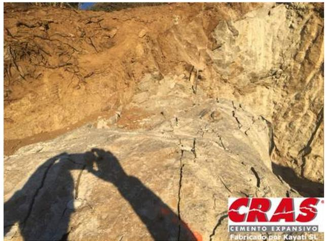
La demolición no explosiva, basada en la fuerza expansiva generada por la reacción de hidratación que se produce en el cemento demoledor permite llevar a cabo demoliciones sin afectación al entorno, con un uso limitado de maquinaria auxiliar y en tiempo reducido,
