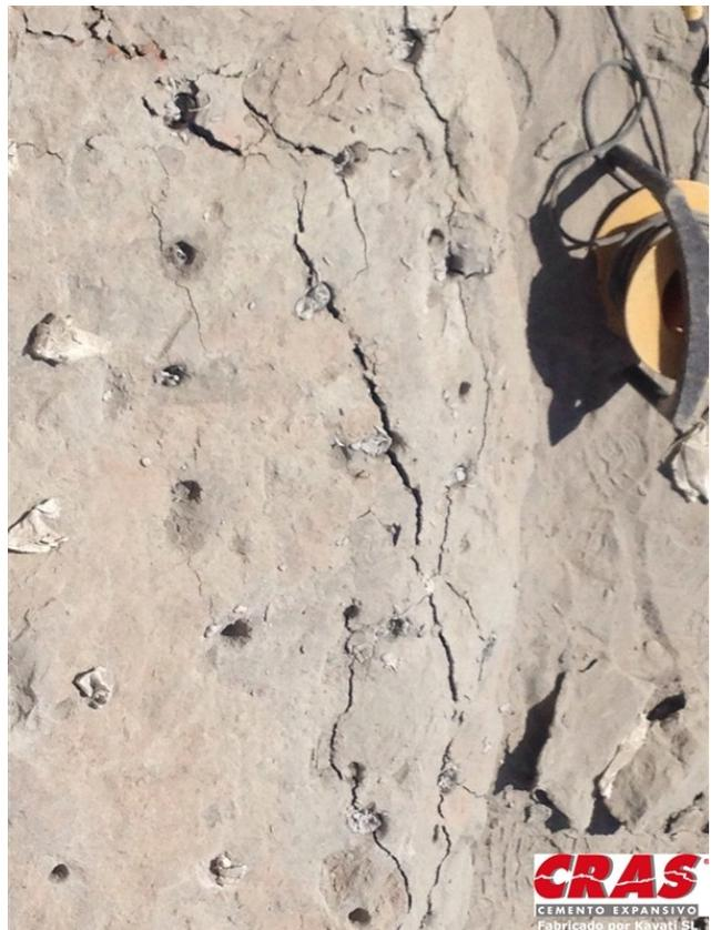
Los responsables del proyecto pensaron, como segunda alternativa, el uso de maquinaria pesada. Sin embargo, se terminaron decantando por el uso del CRAS, cemento demoledor fabricado por la empresa alavesa Kayati SL.
