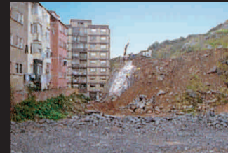
Desmorte entre edificaciones 6.800 m 3 Altura 13 m.
