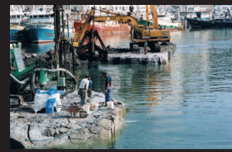
Muelle de Ondarroa 5.000m 3 \phi 70 Profundidad 9 m.
