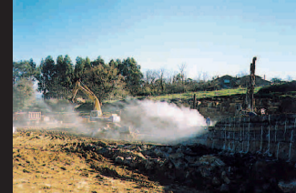
Gran desmorte 36.500 m 3 Altura 15 m.
