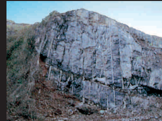
Desmorte entre edificaciones 6.800 m 3 Altura 13 m.
