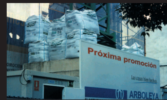
Vaciado entre viejas edificaciones.
