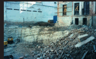
CRAS DEMOL se consagra en demolición SUBMARINA .
